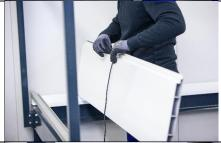
mitgelieferten Dichtgummi d5 in den dafür vorgesehenen Kanal des balkoFLOOR® 333 Paneels einarbeiten (Im ersten Paneel am Anfangsprofil, mit Moosgummi d5 F2)
